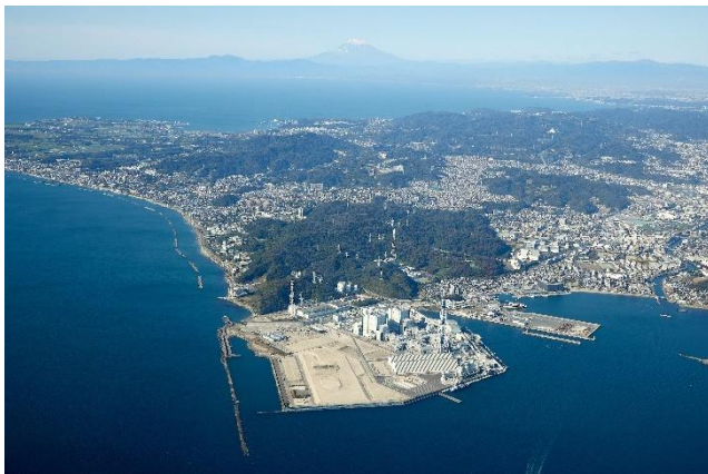
横須賀火力発電所の全景
