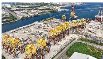
若松工場における洋上風力基礎構造物の製作状況
